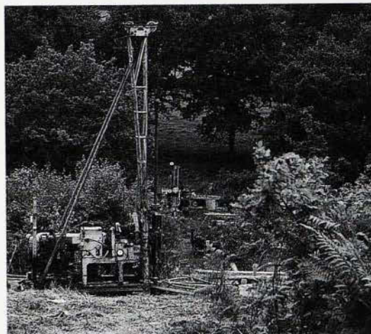
Forage dans la vallée de la Sienne (50)
