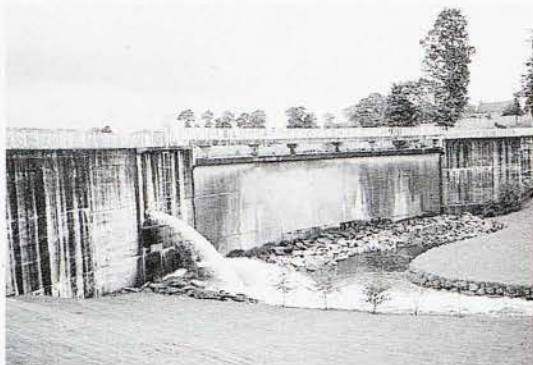
Barrage de la Dathée
